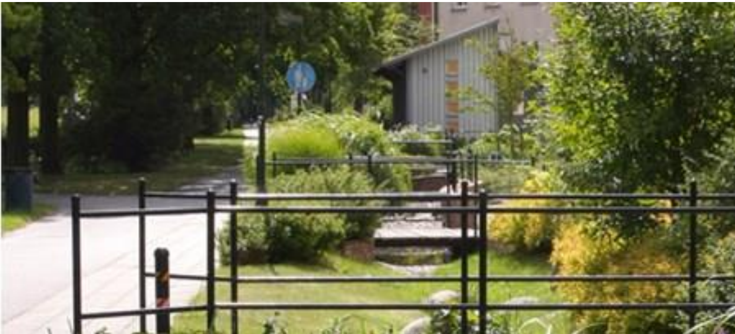
Grøn Regnvandskanal i Augustenborg. Af Malmö Kommune, malmo.se/sustainablecity
